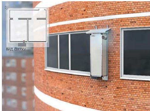
Монтаж на вертикальной раме на улице. Способ 1.
