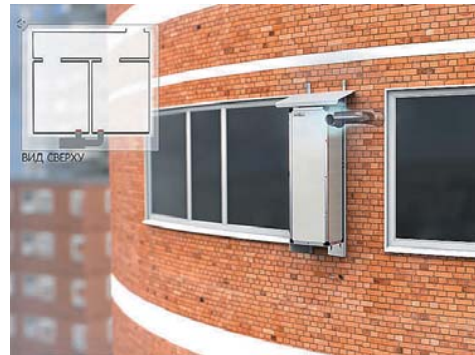
Монтаж на вертикальной раме на улице. Способ 2.
