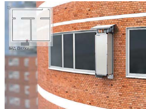
Монтаж на вертикальной раме на улице. Способ 3.
